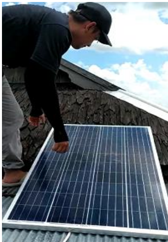
Gambar 4. Pemasangan panel surya
