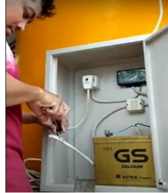
Gambar 5. Perakitan controller dan baterai
