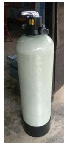
Gambar 2. Tabung filtrasi air
