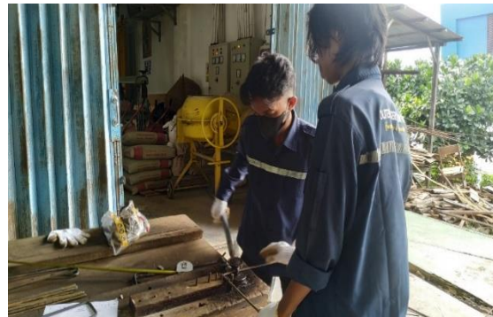
Gambar 6. Proses Pabrikasi Pembesian Untuk Pekerjaan Struktur Toilet
