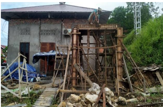
Gambar 8. Penyelesaian Pekerjaan Struktur Toilet Musholla Jabalus Salam
