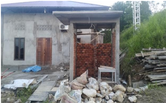
Gambar 9. Pekerjaan Pemasangan Dinding Musholla Jabalus Salam
