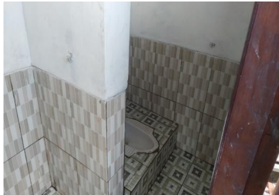
Gambar 11. Hasil Dari Pekerjaan Keramik dan Pengecatan Dinding Bagian Dalam
