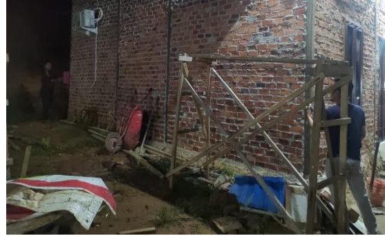
Gambar 3. Pengukuran Ulang Kondisi Eksisting Musholla Jabalus Salam
