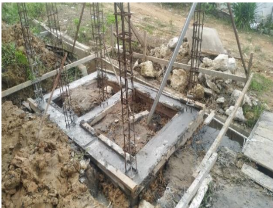
Gambar 7. Pengecoran Pondasi Dan Sloof Struktur Toilet
