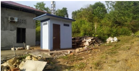
Gambar 12. Hasil Dari Pelaksanaan Pembangunan Toilet Musholla Jabalus Salam
