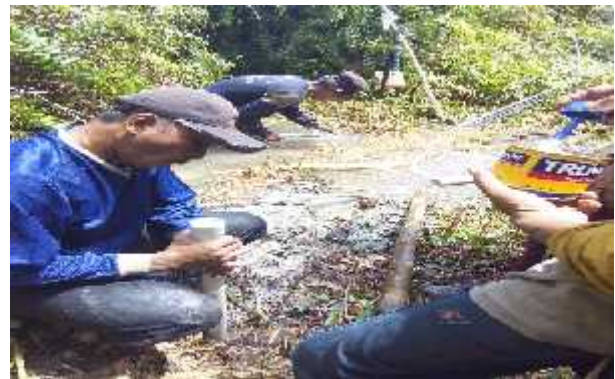
Pemasangan pipa paralon
