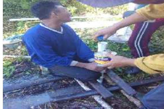
Pemasangan pipa paralon
