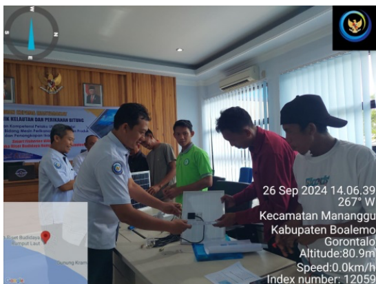
Gambar 6. Praktik Langsung Pemasangan Panel Surya
