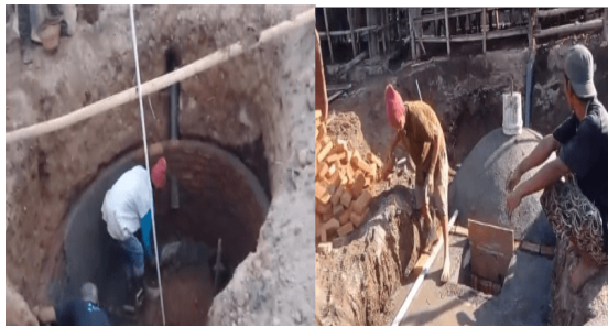
Gambar 4. Proses pembangunan digester biogas tipe fixed dome 4m
